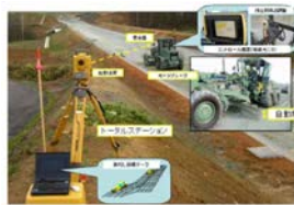
ICT建機による敷均し
