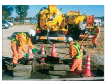
高圧洗浄車及び側溝清掃車を使用して、道路側溝に堆積したゴミ・土砂を除去する。
